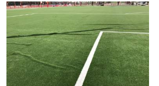
レッズランド：人工芝Gは汚泥除去と消毒を終えたが、人工芝が浮いてしまっており大規模な補修が必要な状況。
